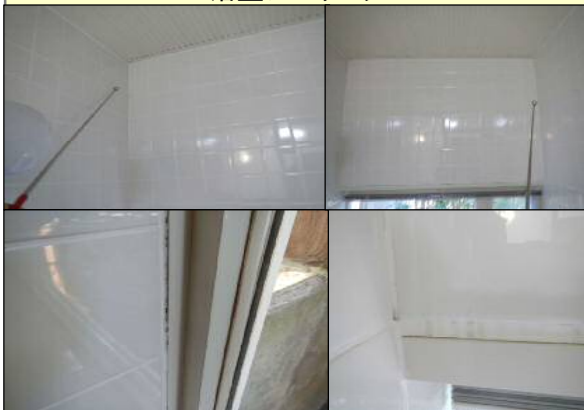
浴室シーリング
