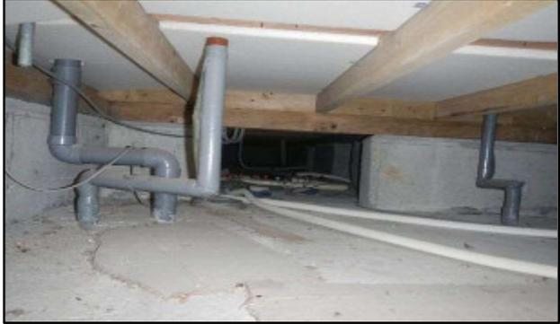
配管は漏水無く良好な状態でした。左は洗濯機給排水。右はトイレ給水。
