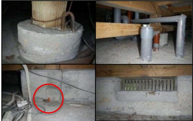
床下配管は漏水など無く、良好な状態でした。左下は残置された設備端材。
