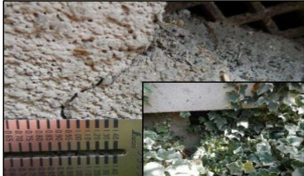
基礎モルタルに基準を超える0.95mmの割れが見受けられました。植物が通風口を塞ぎ、通風を妨げている状態でした。(既存建物西面)
