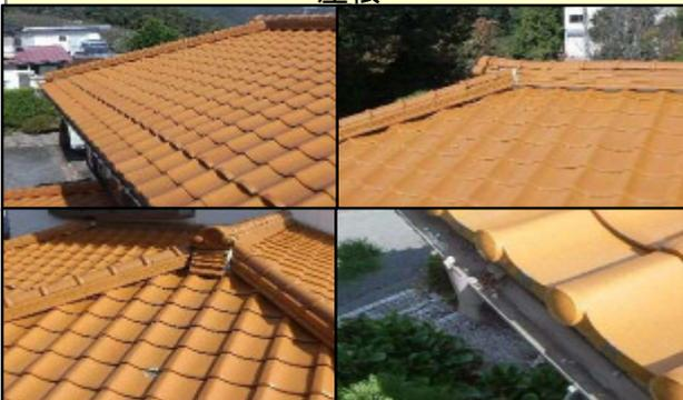
瓦屋根各所。右上写真は棟瓦に若干ずれている事が感じられます。右下は樋内部のゴミの様子。
