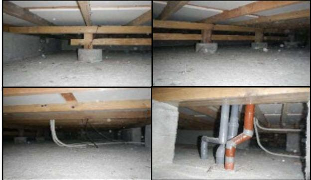
アイボリーに見えるのが床下の断熱材。右下は洗面化粧台給排水。
